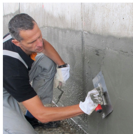
PCI Barraseal má plasticko-krémovitú konzistenciu. Póry a priehlbiny sa ľahko a rýchlo vyplnia.
