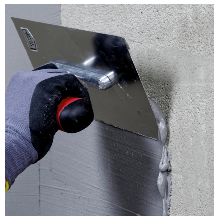
Kontaktná vrstva sa môže naniesť aj hladidlom vo forme penetračnej stierky.
