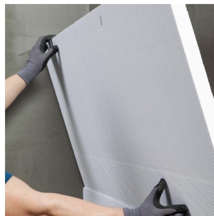
S PCI Barraseal Turbo sa môžu na vytvrdnutý podklad lepiť drenážne a izolačné dosky.
