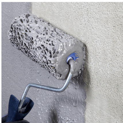
Nanesenie kontaktnej vrstvy valčekom.
