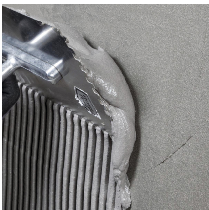
PCI Barraseal Turbo sa musí nanášať minimálne v dvoch vrstvách. Kvôli kontrole hrúbky vrstvy sa materiál môže naniesť ozubeným hladidlom a potom vyhladiť.
