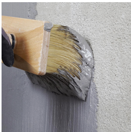
Nanesenie kontaktnej vrstvy štetkou alebo štetcom.
