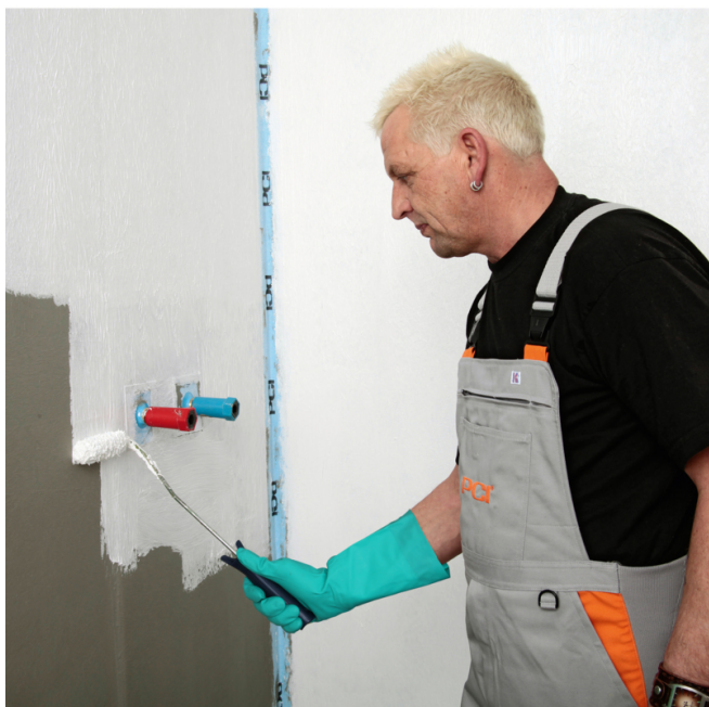
5. Po dobe odvetrania cca 1 hod. naniesť druhú vrstvu s PCI Lastogum (weiß). Prvá vrstva nesmie presvitať, v prípade potreby znovu pretrieť.
