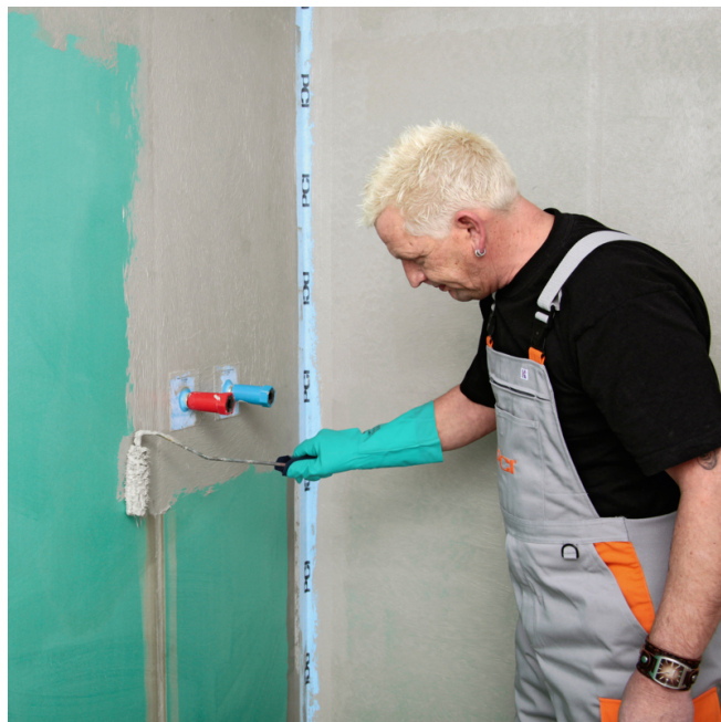
4. Prvá vrstva PCI Lastogum (grau) neriedený naniesť celoplošne a sýto na podklad.
