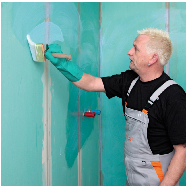
1. Penetrácia: Savé minerálne alebo sadrové podklady a sadrokartónové dosky penetrovať s PCI Gisogrund.
