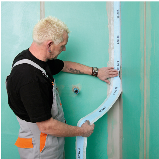
3. PCI Pecitape 120 nalepiť s PCI Lastogum (grau) do rohových škár a napojení stena-podlaha.
