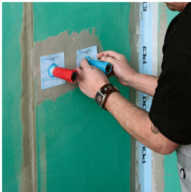
2. Zo steny vyčnievajúce prestupy rúr prekryť s PCI Pecitape 10 x 10 a prilepiť s PCI Lastogum.
