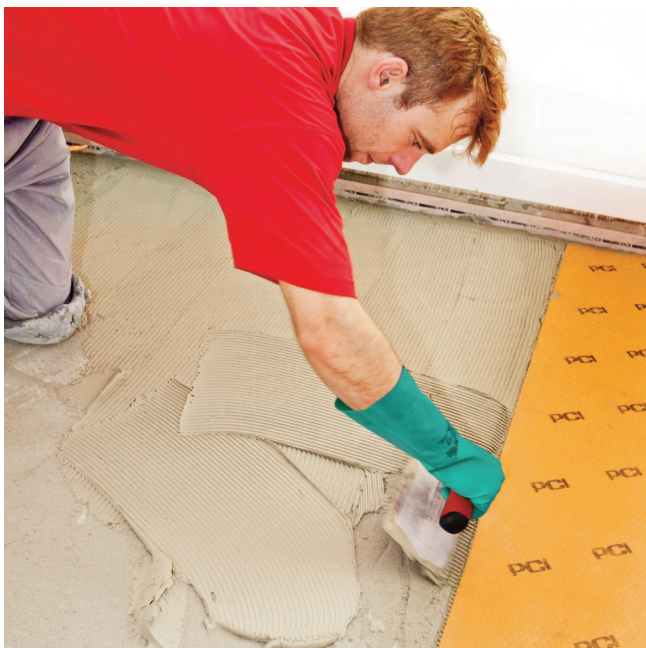
Na pripravený podklad naniesť PCI Nanflott light alebo PCI Rapidflott ...
